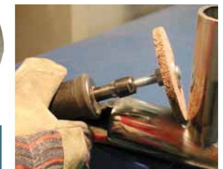
Удаление сварного шва в труднодоступных местах
