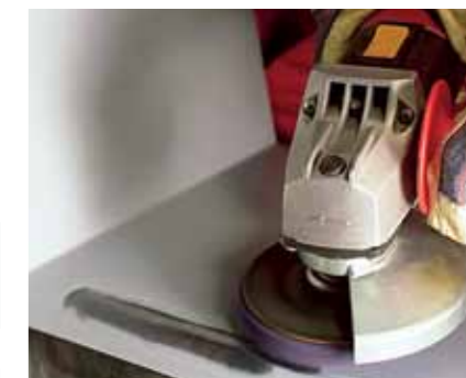
Удаление старого покрытия
