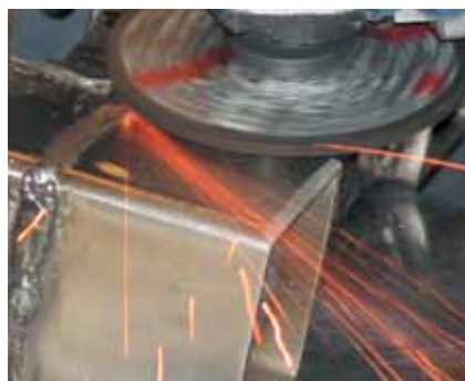
Удаление сварного шва
