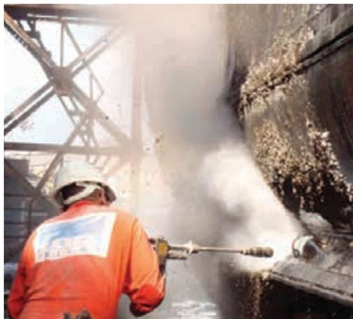
◀ Идеально подходит для чистки палуб и трюмов грузовых судов. Более того, с данными аппаратами возможна беспылевая пескоструйная чистка. Аппараты разработаны не только для мойки поверхностей, они также применяются для чистки от налета, сажи, ржавчины, граффити и даже дробления бетона.
