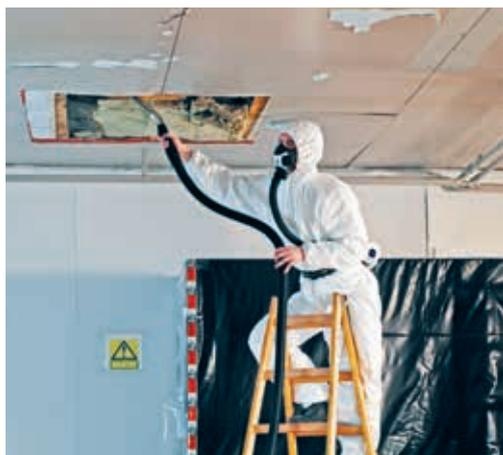
◀ При работе с взрывоопасной пылью Н-класса или асбестом безопасность и беспылевая работа – ключевое требование. Серия наших сертифицированных пылесосов Н-класса – безопасное и простое в использовании решение.
