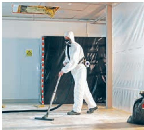
◀ Все модели Н-класса оснащены безопасным фильтр-мешком Nilfisk-ALTO – герметичная система опустошения, обеспечивающая дополнительную безопасность во взрывоопасной среде. При замене фильтра не происходит распространения пыли.
